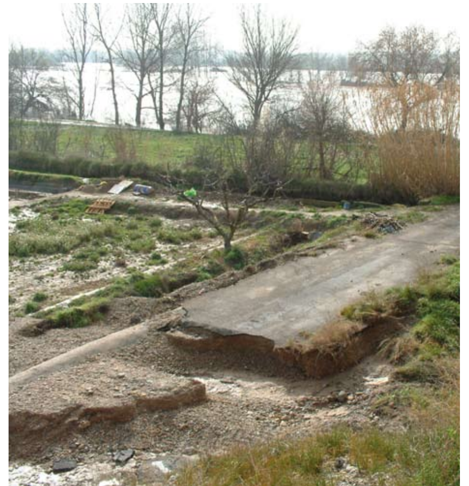
Daños en caminos y campos del término municipal de Gallur ocasionados por una avenida del Ebro.
